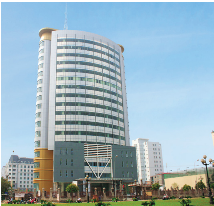
Trung tâm mạng viễn thông liên tỉnh phía bắc Đường Phạm Hùng, Q. Nam Từ Liêm, Hà Nội
